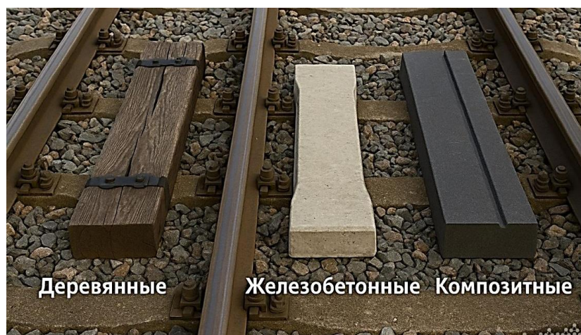
Рисунок 1 – Виды железнодорожных шпал
