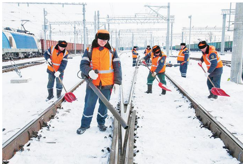
Рисунок 1 – Очистка стрелочного перевода на станции Никель
